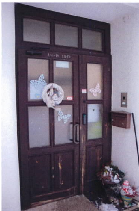
Fotodokumentace – stávající dveře
