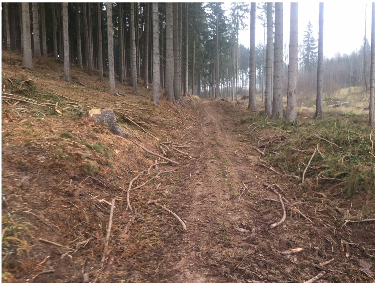
Foto 4 – km cca 0.300 (opětovně zamezení odtoku, příčná nerovnost)
