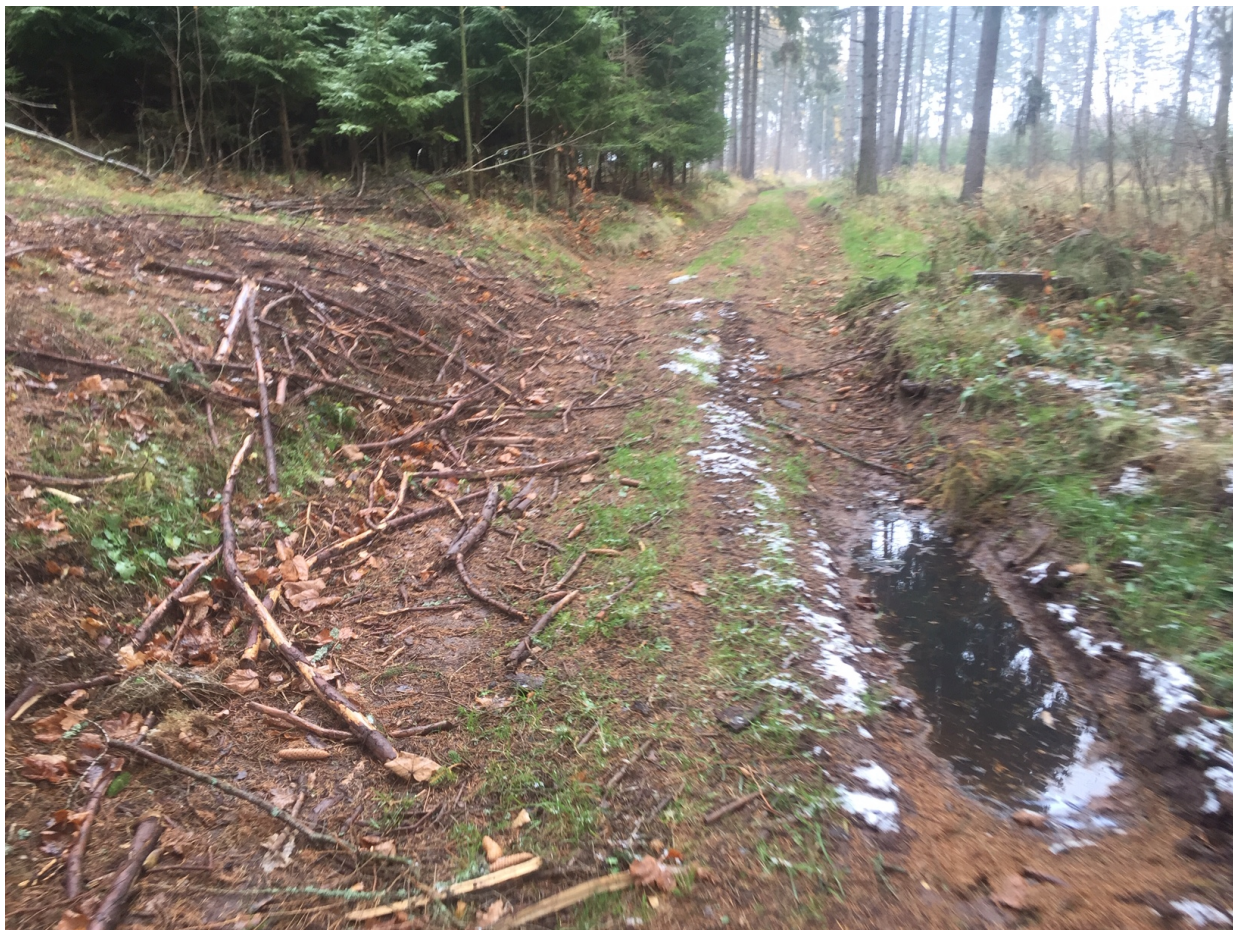
Foto 5 – km cca 0.500, pokles komunikace, tvorba kaluží s podmíčením
