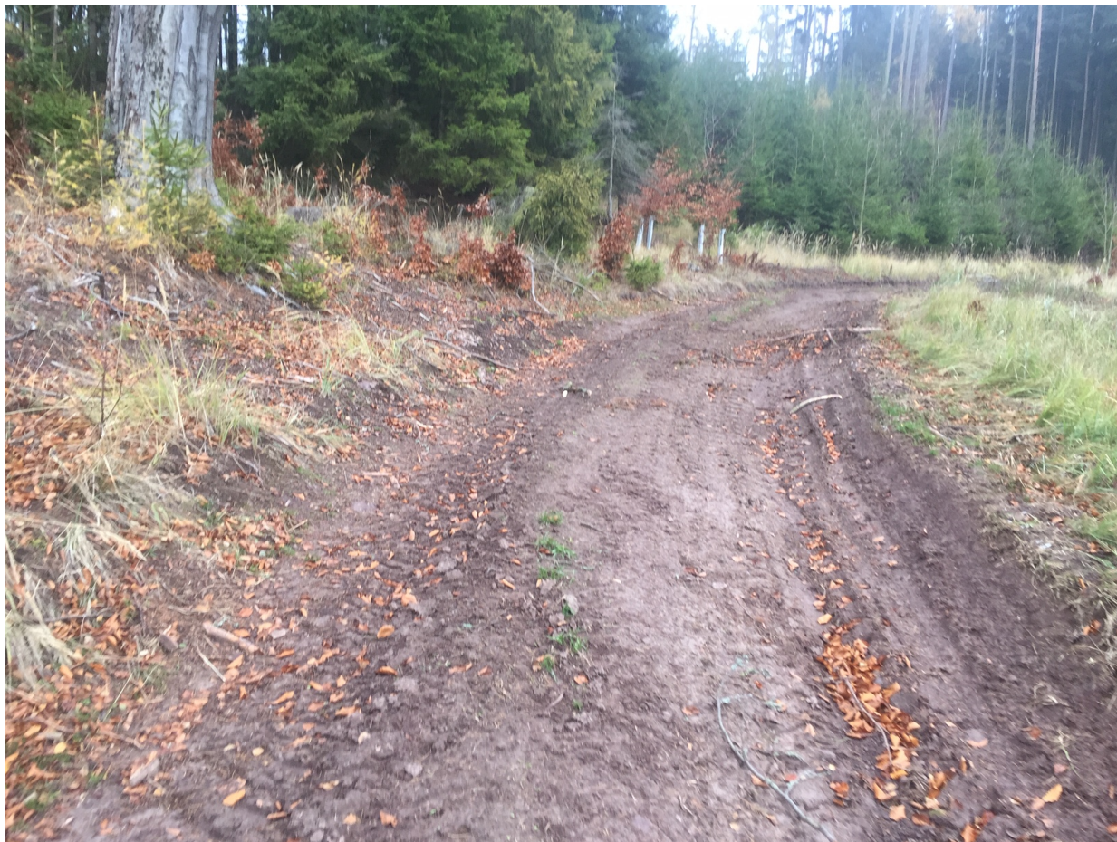
Foto 3, km cca 0.230 – úplné zamezení umožnění odtoku dešťových vod, příčná nerovnost v řádech dm
